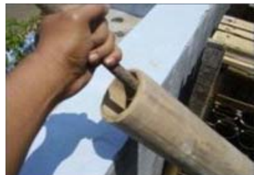
Gambar 2. Proses pemotongan dan pelobangan bambu.
